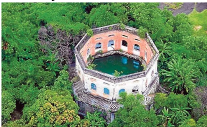
Figura 12: Vista aérea do reservatório
