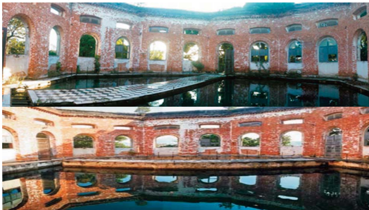
Figura 11: Vista interna do reservatório da Quinta da Boa Vista
