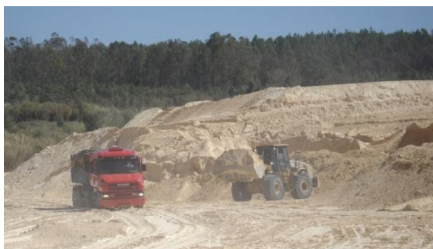
Figura 5 - Disposição a seco do fosfogesso Fonte - MATOS, 2011.
