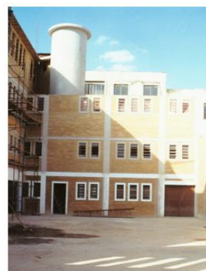
Figura 1 - Escola em Contagem-MG, Brasil. Fonte: Alvarenga (2011).
